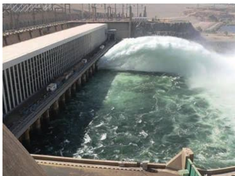
Рис. 60. Асуанская ГЭС в г. Асуан
